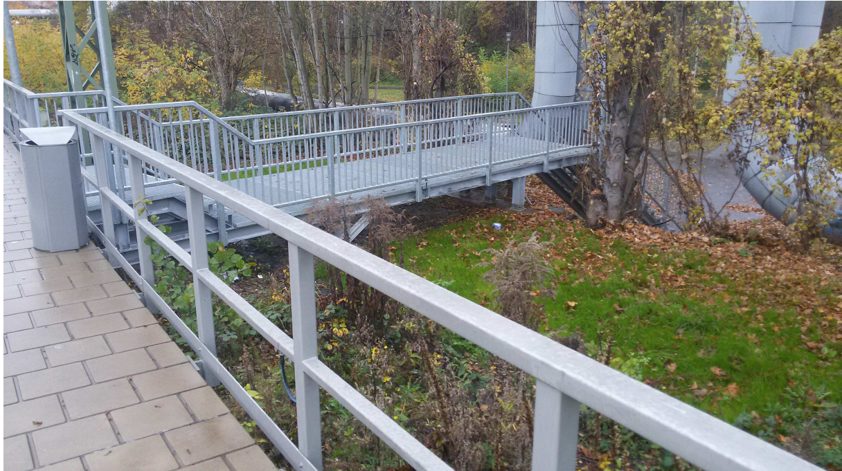
Zweiter Zugang Hp Anger-Crottendorf mit Blickrichtung Radweg „Anger-Crottendorfer Bahnschneise“
