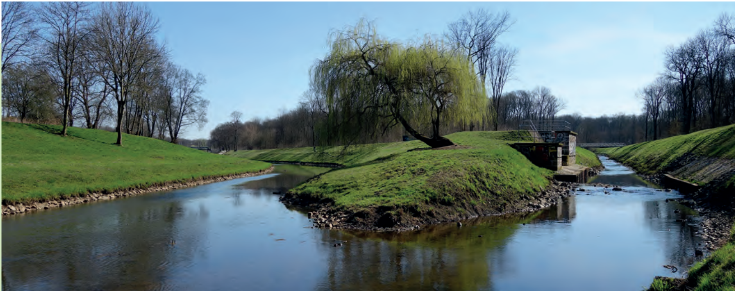
Zusammenfluss von Kleiner Luppe und Nahle: Das Wasser für die Lebendige Luppe soll im Niedrig- und Normalwasserfall aus der Kleinen Luppe (rechts) entnommen werden. Im Bild zu sehen ist auch der Auslass der Leipziger Wasserwerke (Mauerwerk mit Geländer). Foto: Maria Vitzthum
