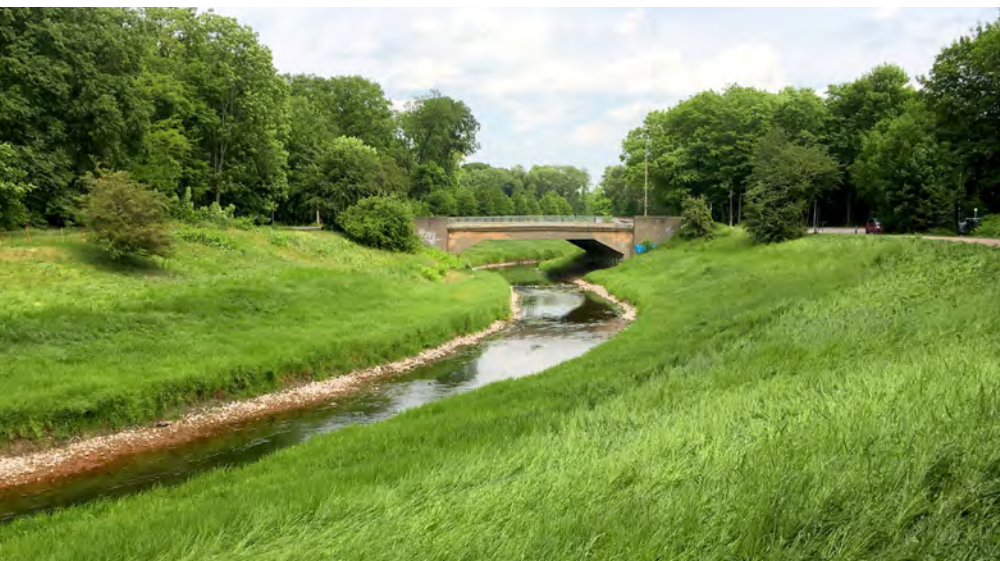
Die Nahle führt seit geraumer Zeit Niedrigwasser aufgrund von Wasserbauarbeiten im Oberlauf (Niedrigwasserabfluss ca. 0,5 m³/s). Foto: Jens Riedel
