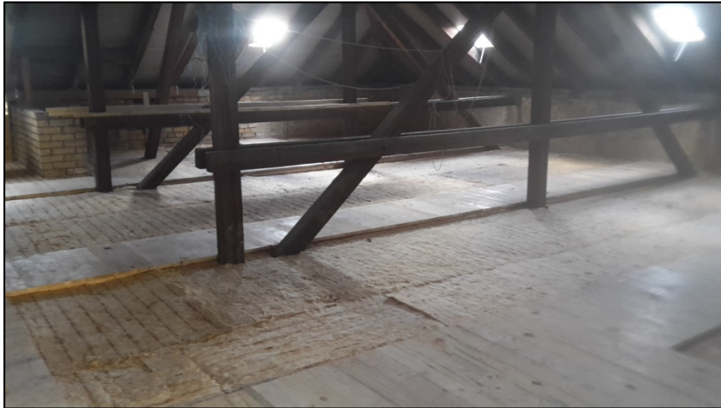
Abbildung 1: Neue Dämmung in der Grundschule Holzhausen (Foto: Stadt Leipzig)
